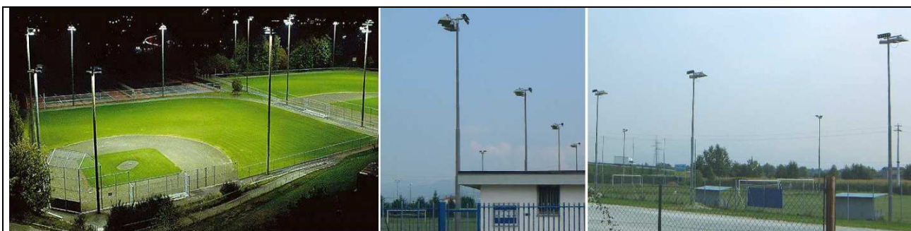
Figura 2.13 - Impianti sportivi illuminati in modo conforme alla L.R. 17/00 con proiettori asimmetrici orientati orizzontalmente e che non disperdono luce verso l'alto.
